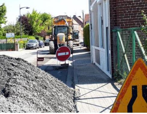
Après environ 6 mois de travaux, le réseau unitaire d'eaux pluviales et d'eaux usées (y compris celles de Wannehain), d'une partie de la rue Foch et de la rue Doumer a été remplacé par deux nouveaux réseaux :
