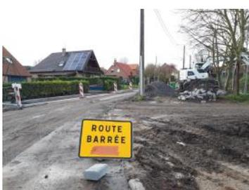
la météo très capricieuse et un problème technique sur la réalisation d'une partie des trottoirs en béton désactivé de la rue Doumer, nous a contraint à reprendre 50 % de ces trottoirs, ce qui a provoqué un décalage d'un mois.
